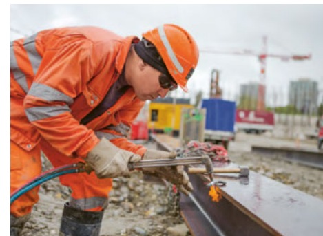
In Genf entsteht die nachhaltige Wohnsiedlung Pont-Rouge gemäss dem deutschen Nachhaltigkeitsstandard DGNB.
